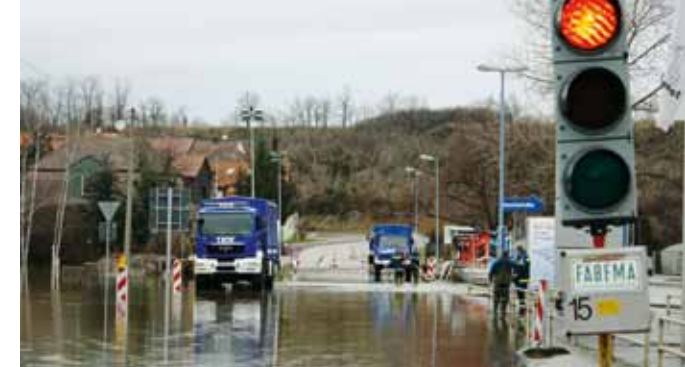
THW pumpte überflutete Straßen nach Saalehochwasser frei
